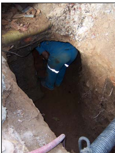
Detall dels treballs de mina per sota de la calçada de la Rambla.
