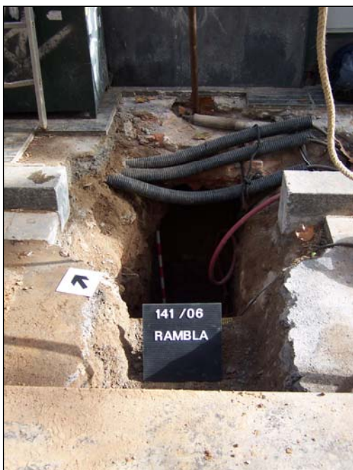
General final de la part de la rasa visible en planta.
